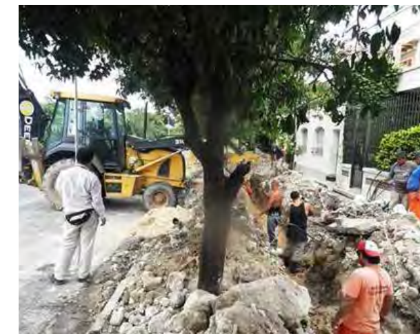
Obras realizadas mediante presupuesto participativo
